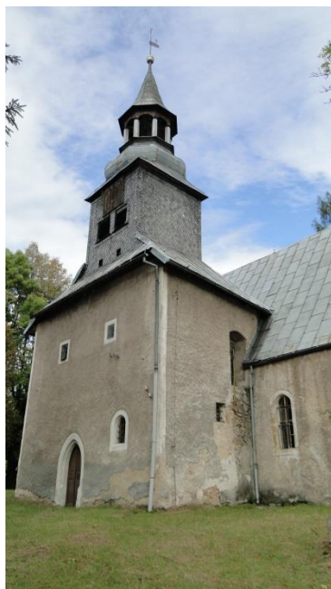
Kościół św. Marcina w Bukowcu
